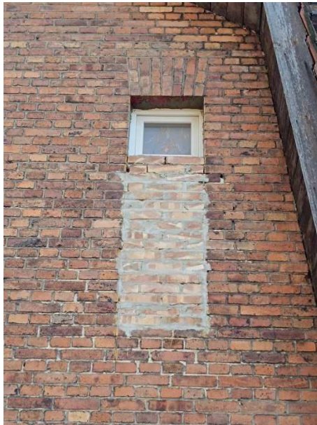
Fot. 7. Zmniejszone okno, przemurowania.
