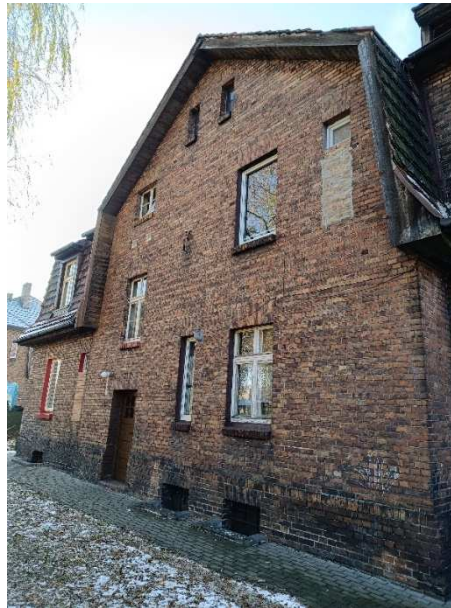
Fot. 8. Elewacja północno-wschodnia – przemurowania.
