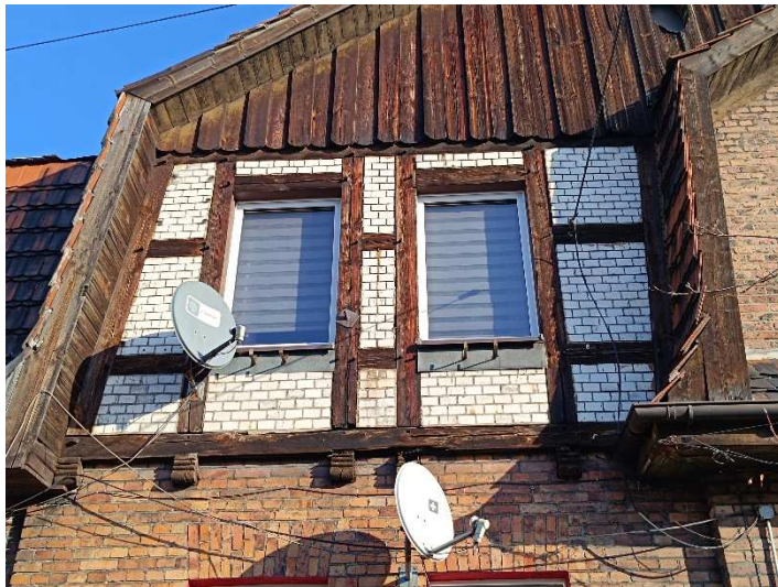
Fot. 18. Mur pruski – elewacja frontowa.
