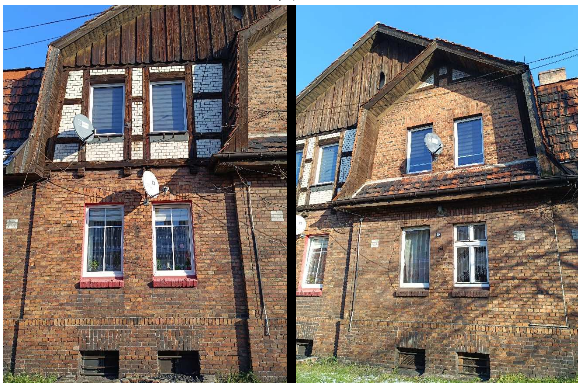
Fot. 5. Elewacja południowo-zachodnia – fragment muru pruskiego. Fot. 6. Fragment elewacji południowo-zachodniej.
